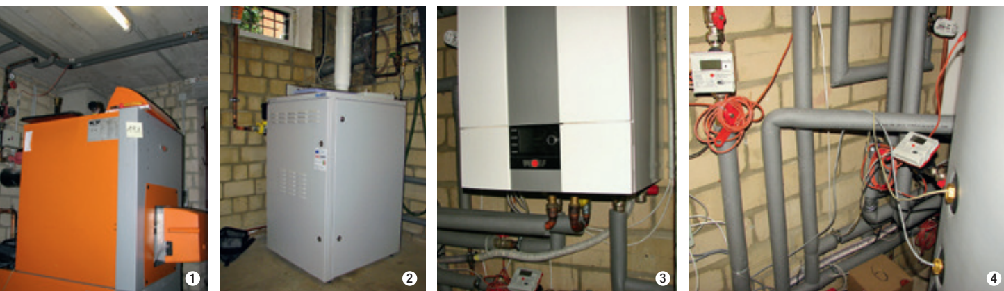
Abb. 5: Die (1) Altanlage wurde ersetzt durch (2) eine Brennstoffzelle und (3) eine Gas-Brennwerttherme inklusive (4) Messtechnik.
