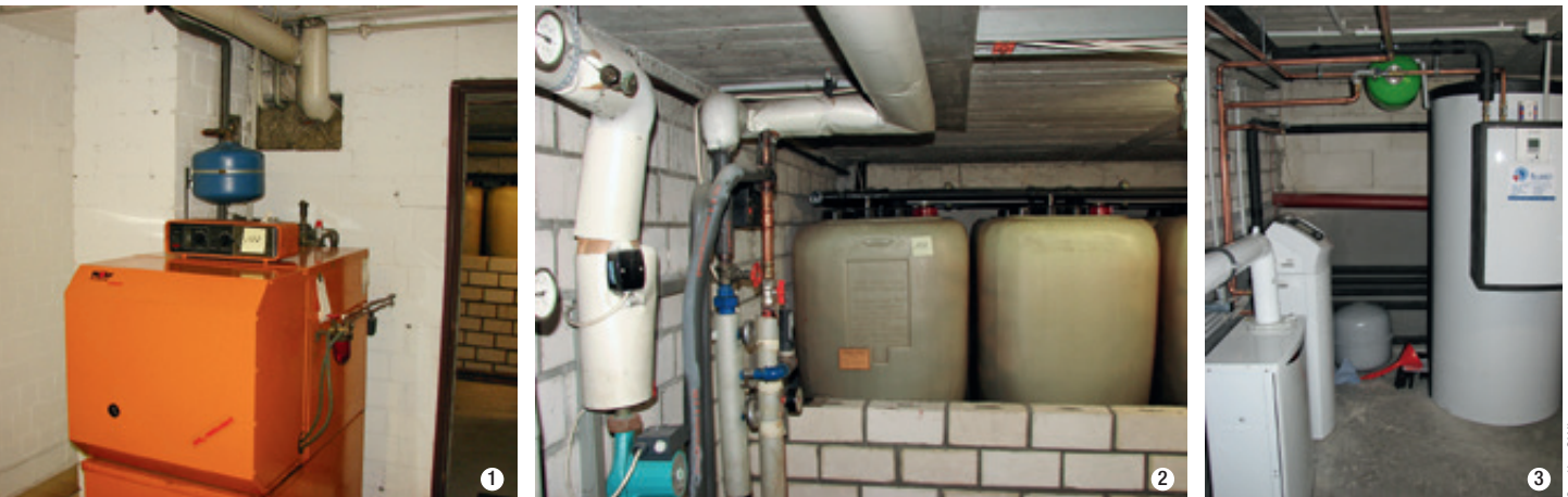
Abb. 4: Die (1) ölbasierte Altanlage mit (2) installierten Öltanks im Vergleich zur (3) Neuanlage (Otto).
